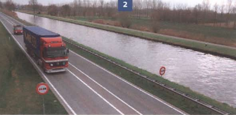
◀ Eén van de moderne provinciale wegen, de N 279, Den Bosch – Veghel
