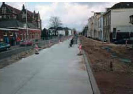
Aanleg van de busbaan door de stad Utrecht
