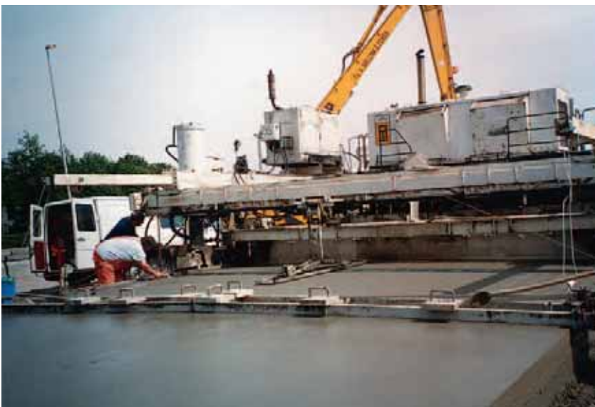
Aanleg onder dakprofiel ▼
