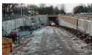
De busbaan bij de Berekuil richting de Uithof, in aanleg ▲
