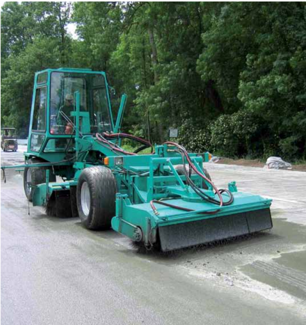
Uitborstelen van beton
