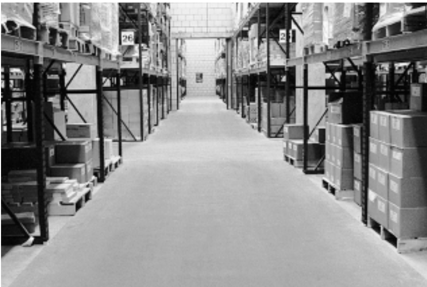
Foto 19: Ultravakke epoxygebonden troffelvloer (10 mm dik) voor rijpaden van een hoogbouwmagazijn met 15 m hoge stellingen (foto: Fa. Possehl, Oosterhout)
