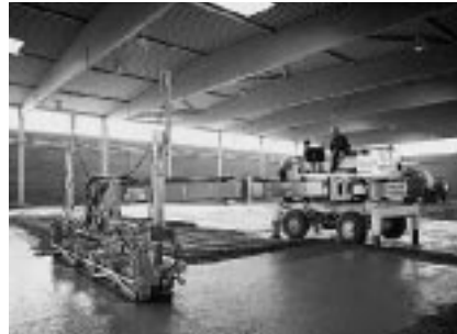
Foto's 58 en 59: Afrei-machines voor machinaal uitvlakken, verdichten en instrooien van betonspecie 'Multi-arm' voor vloeren van 300 tot 2000 m 2
