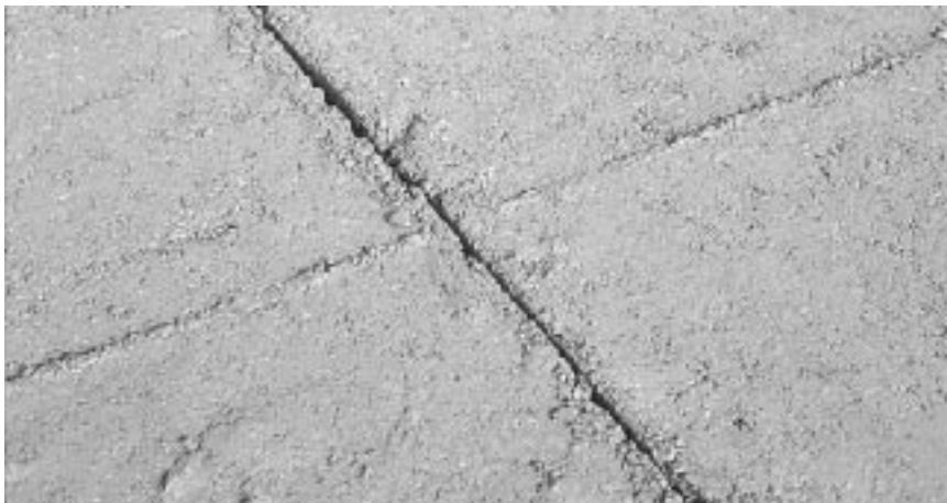
Foto 14: Gekerfd voegenpatroon in een fundering van schraalbeton
