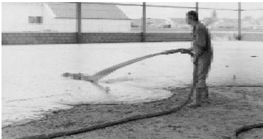
Foto 15: Schuimbeton als ophoogmateriaal bij slappe ondergrond
