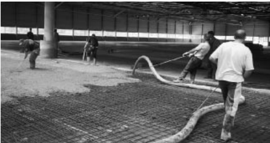
Foto 60: Aanleg betonvloer distributiecentrum PTT te Nieuwegein (Foto: ABT, Velp)
