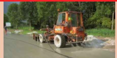
Het uitborstelen van beton
