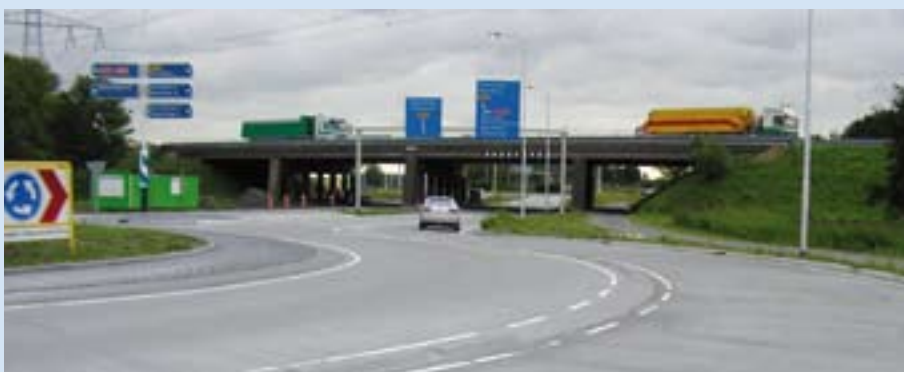
Aansluiting van de N285 ter hoogte van Klundert op de A17 gebeurt met een dubbele betonnen turborotonde (kluifrotonde)
