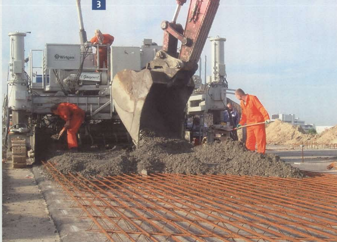
◀ Aanbrengen van de betonspecie vóór de slipformpaver
