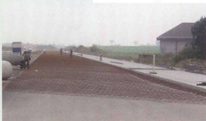
▲ De nieuwe A5, in doorgaand-gewapend beton, zoals die achter de slipformpaver tevoorschijn komt.
