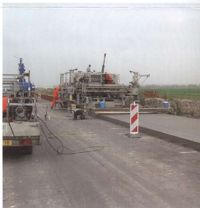
▲ De nieuwe A5, in doorgaand-gewapend beton, zoals die achter de slipformpaver tevoorschijn komt.
