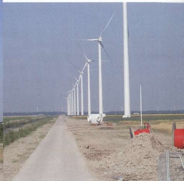
▲ Betonweg in gebruik als bouwweg voor de windmolens
